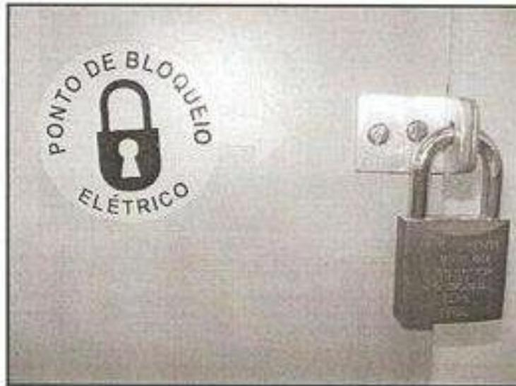
*Ao lado, um interessante expediente adotado para identificar nas instalações os pontos onde são estabelecidos como pontos de bloqueio elétrico. Entretanto, em projeto deve constar a especificação do ponto a ser bloqueado, pelo que nas instalações a correspondência deve ser evidente.*
