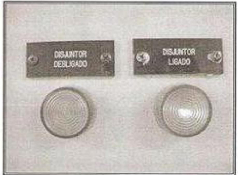
*Acima, exemplos de indicação de posição de um dispositivo de manobra em carga, ou seja, um disjuntor. À esquerda, mecanicamente e, à direita, eletricamente.*
