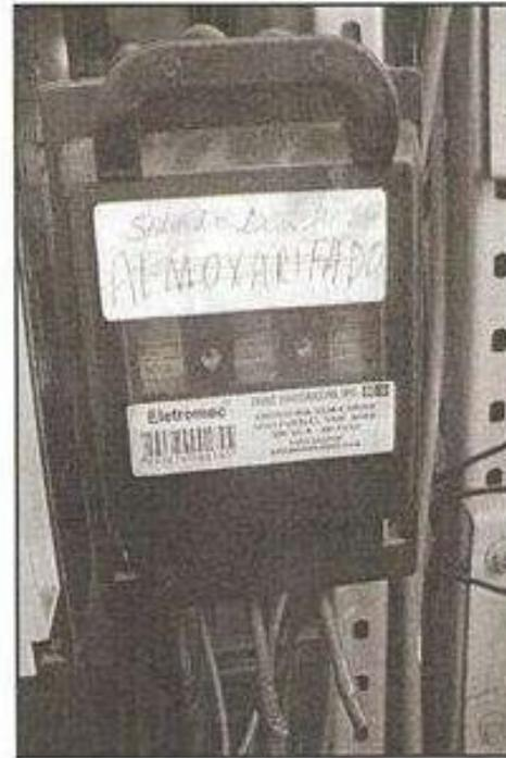
*Acima nota-se a improvisação na identificação de circuitos ou de dispositivos de manobra. Quer por inscrições por meio de pincéis atômicos diretamente na porta do painel, ou por meio de caneta esferográfica (que na foto acima à direita há uma inscrição já rasurada), a identificação precária pode levar um colaborador à exposição a acidentes por comunicação falha.*
