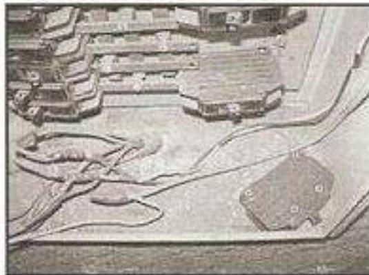
*Imediatamente acima, dispositivos de proteção fusível e disjuntores deixados indevidamente dentro de painéis elétricos.*
